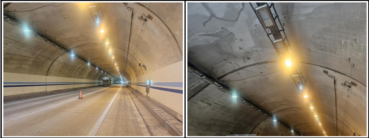
【사진 5.3.15】 라이닝 천단부 전경
