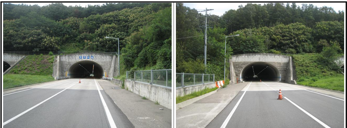
【사진 5.3.5】 갭문 전경
