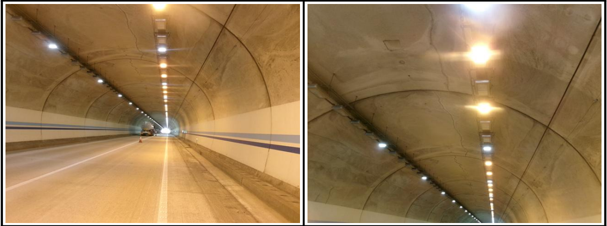
【사진 5.3.1】 라이닝 천단부 전경
