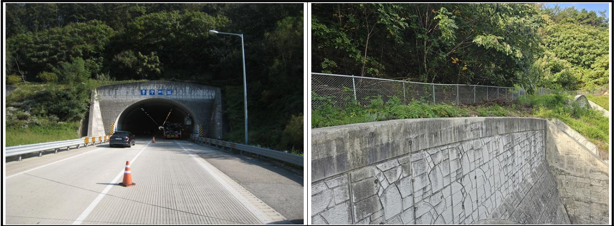
【사진 5.3.21】 사면 전경
