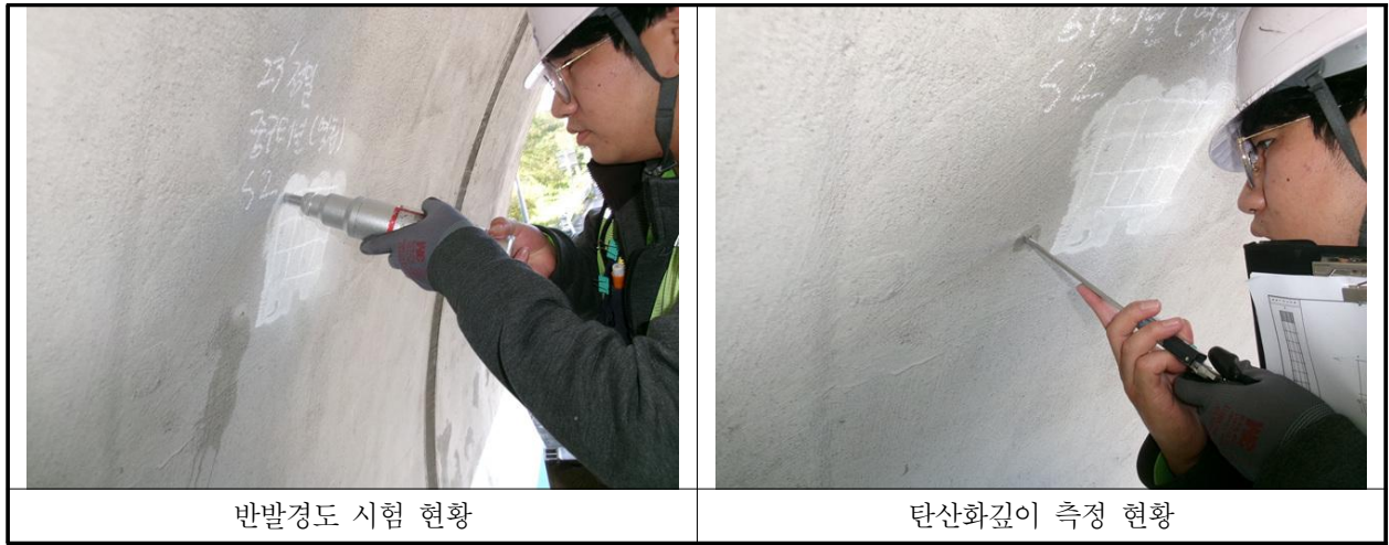
【사진 5.4.1】 콘크리트 내구성조사 현황
