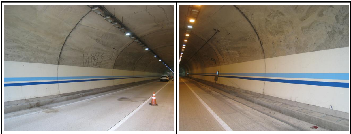
【사진 5.3.3】 라이닝 측벽부 전경
