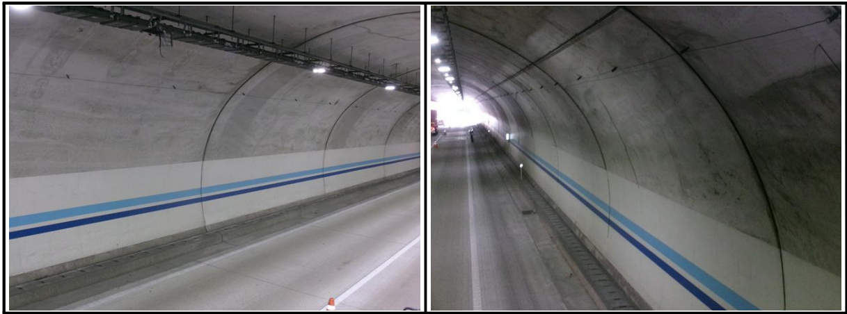
【사진 5.3.17】 라이닝 측벽부 전경
