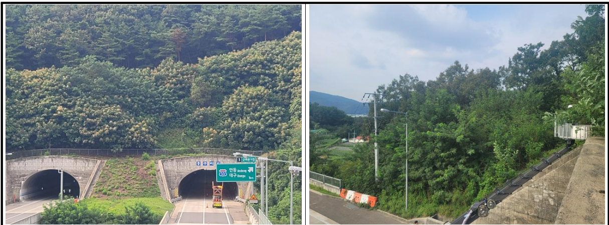
【사진 5.3.7】 사면 전경
